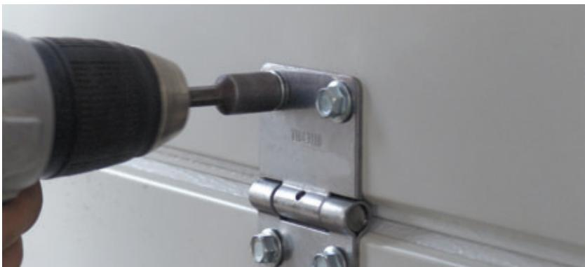
В конструкции используются боковые кронштейны и промежуточные петли из нержавеющей стали для соединения панелей. Это гарантирует высокую коррозийную стойкость различных элементов конструкции, таких как петель и кронштейнов, соприкасающихся друг с другом.
